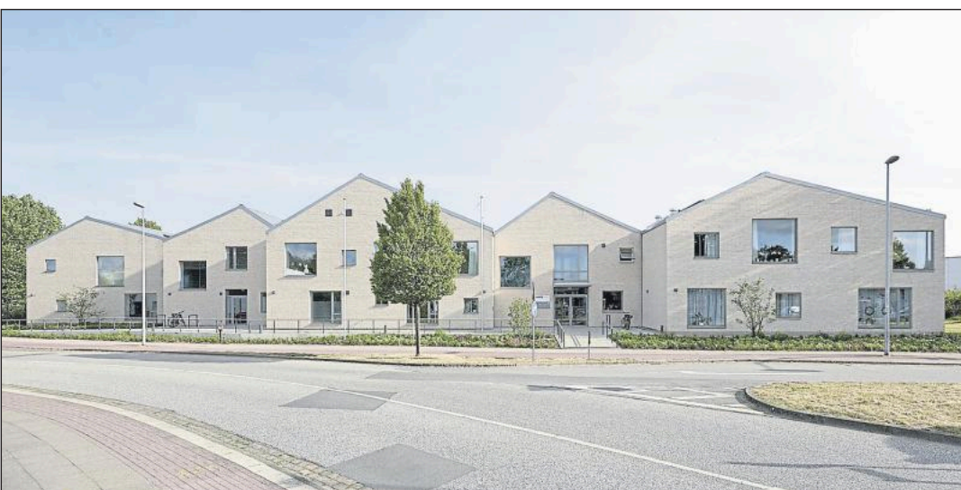
Wohnheim an der Büsumer Straße in Heide.
