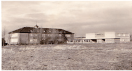
Das Schulgebäude in den 70er Jahren
