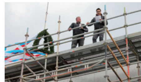
Eine weitere Etappe ist geschafft: Dichtfest am 12.5.2017
